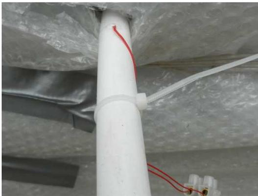
**Abbildung 24: Temperaturfühler Wärmeübertragerausgang**
