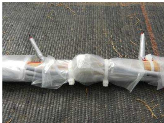
**Abbildung 13: Abdichten der Kabelverbindung**
